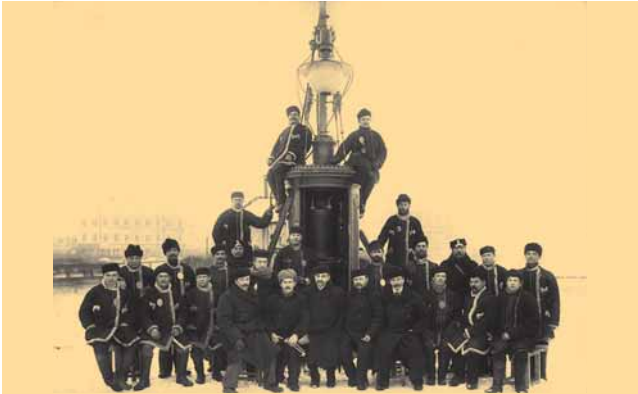
Группа рабочих у установленного фонаря
