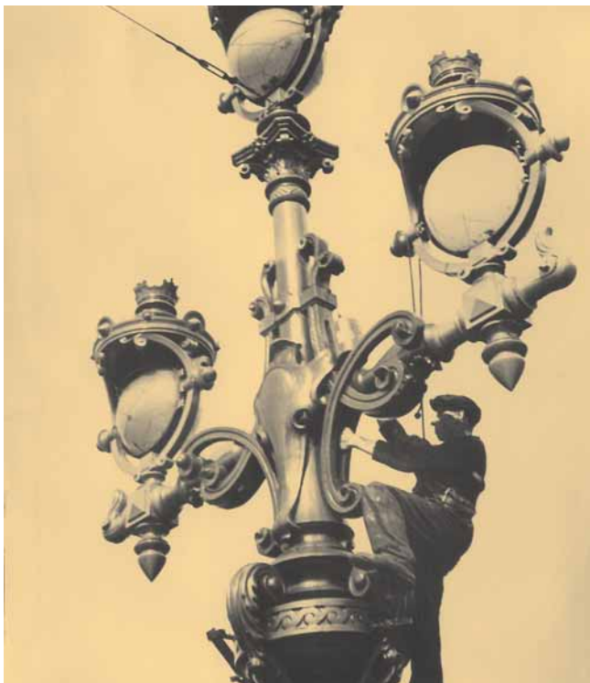
Кировский мост. Окраска фонарей. Ленинград, 1936 г.
