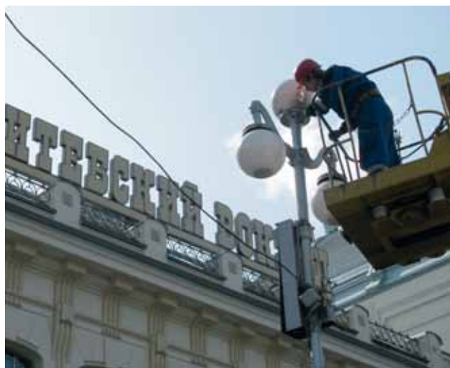
Работы по замене светильников у Витебского вокзала
