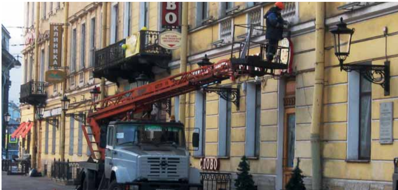
Работы по монтажу подсветки
