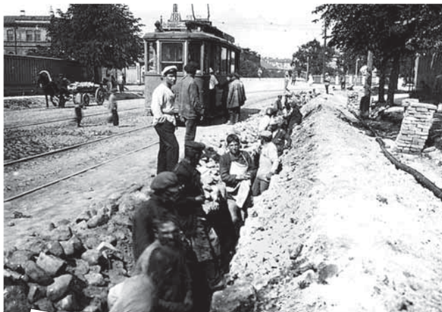
Прокладка кабеля 35 кв. 1925 г.
