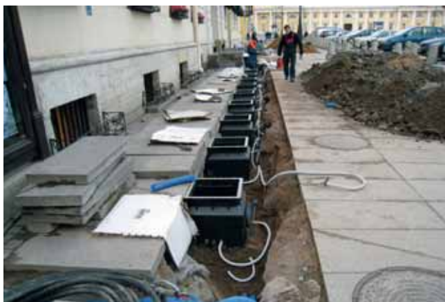
Установка светодиодных прожекторов на площади Искусств
