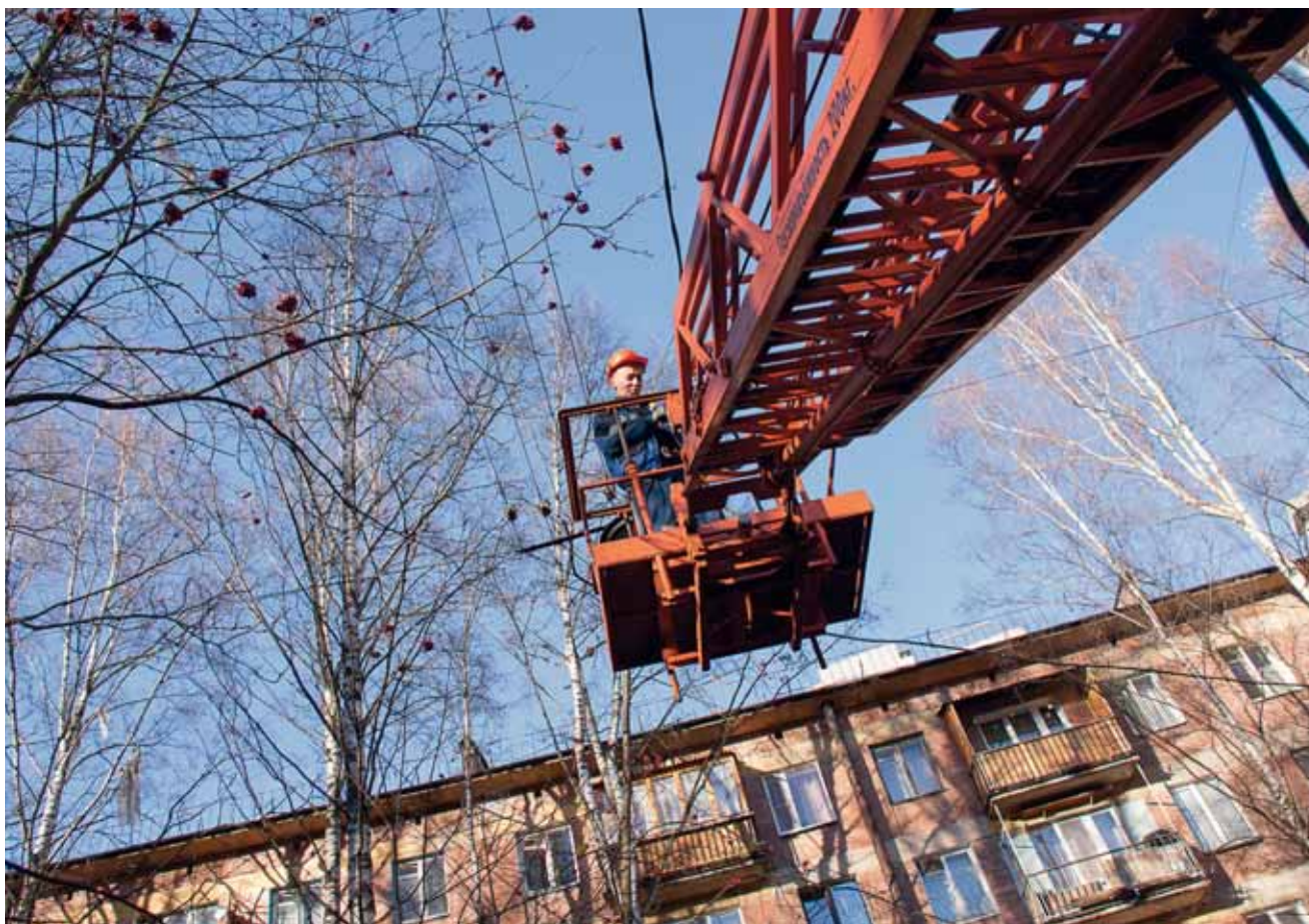
Ремонтные работы по квартальному освещению
