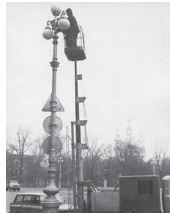
Работы по замене ламп фонарей
