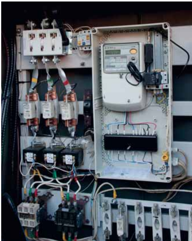
Пусконаладка светодинамических приборов архитектурно-художественной подсветки телебашни
