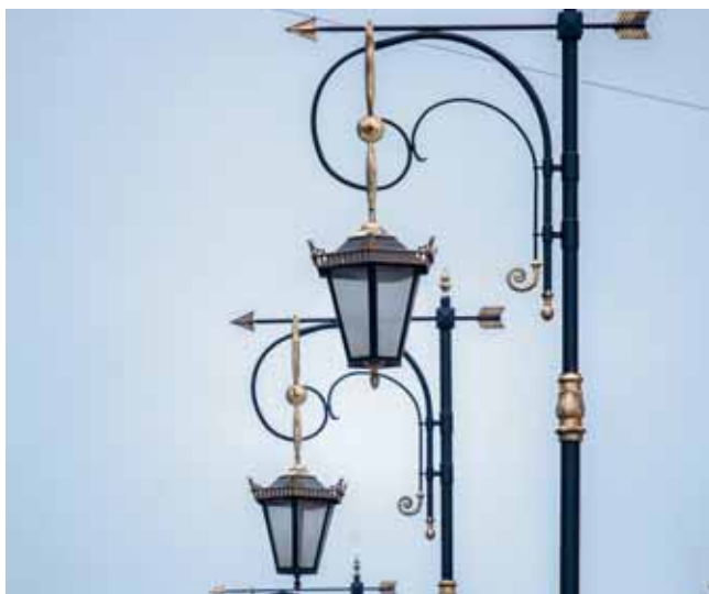
Комплексная реконструкция наружного освещения на улице Пестеля
